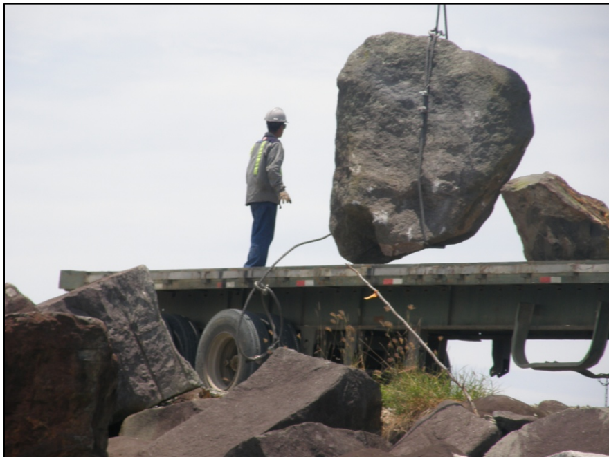
Figura 5. Roca basáltica levantada por grúa. Tamaños similares o un poco más pequeños si se colocan en sitios adecuados se adaptan bien al fondo marino (Segura, A. 2013).
