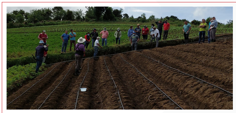
Figura 10. Práctica instalación riego por goteo
